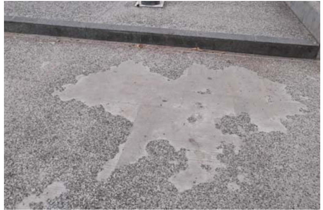
ピストバイクによる舗装面の破損
