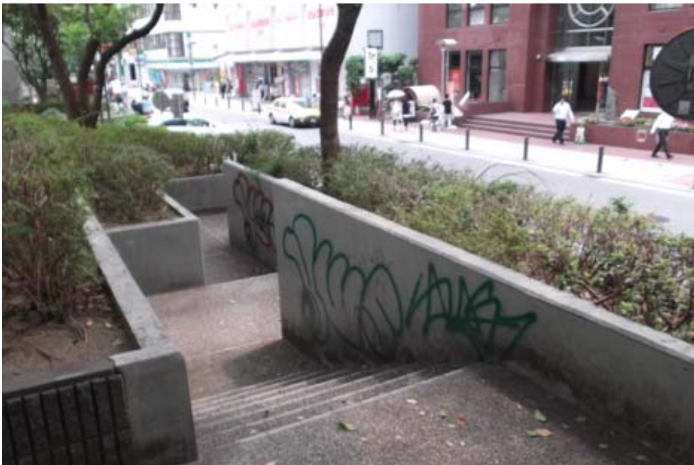
警固公園通り側通路の壁の落書き
